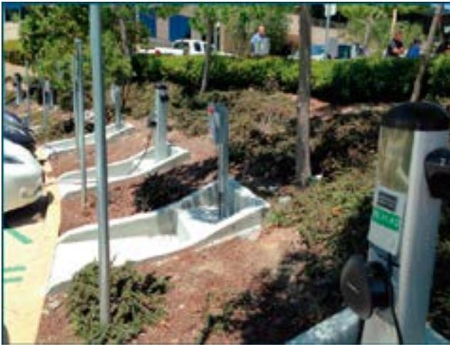
*Figura 4.6: Estaciones de carga para vehículos eléctricos en las instalaciones de SAP en Palo Alto (Foto: Tony Seba)*
